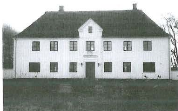
Herregården Strandet's hovedbygning er opført i 1798. Den indeholder dele af en ældre bygning. Bygningens Louis Seize-stil udtrykker arkitektonisk enkelthed. Bemærk den smukke hoveddør.
