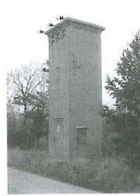
Det murede transformatorårns præcise form understreges af det flade betontag og de cementstøbte vandnæser over dør og lem.
