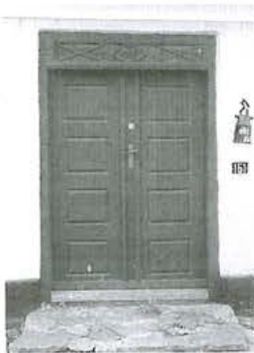
Lundøvej 151. Nyere dør tilpasset den oprindelige dørtype.
