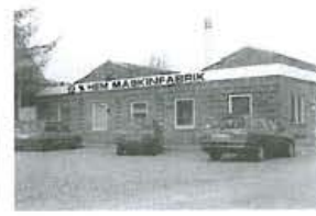
Hem Maskinfabrik er et eksempel på tidlig industriarkitektur på landet. Bemærk fabrikkationshallerne med ovenlys bag forbygningen. Forbygningen har klassicistiske stiltræk.
