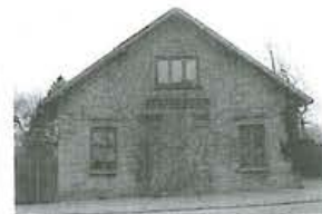
Østerrisvej nr. 5 har pyntelige udhængsspær.
