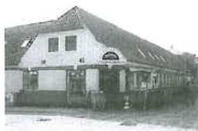
Nørregade 32, opført 1841. Det klassicistiske anlæg hører til de ældste bygninger i Skive.
