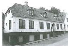
Det klassicistiske længehus, Østergade 10, er en af de mest værdifulde bygninger i Skive.
