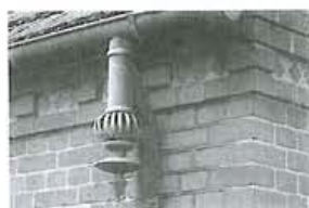
Det meget smukke tagnedløb vidner om en tid, da praktiske løsninger blev kombineret med æstetik og dygtigt håndværk.
