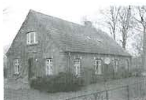
Lundøvej nr. 11 er et smukt eksempel på håndverkets høje kvalitet. Bortset fra gavlvinduet og den nyere hoveddør er bygningen meget velbevaret. Cementtagstenene og de oprindelige vinduer bør fremhæves som værdifulde detaljer.
