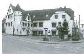
Den rigt detaljerede Højslev Kro (tegnet af arkitekt Erik V. Lind i 1905) markerer sig kraftigt i bybilledet og danner sammen med de øvrige stationsbyhuse en bevaringsværdig helhed.
