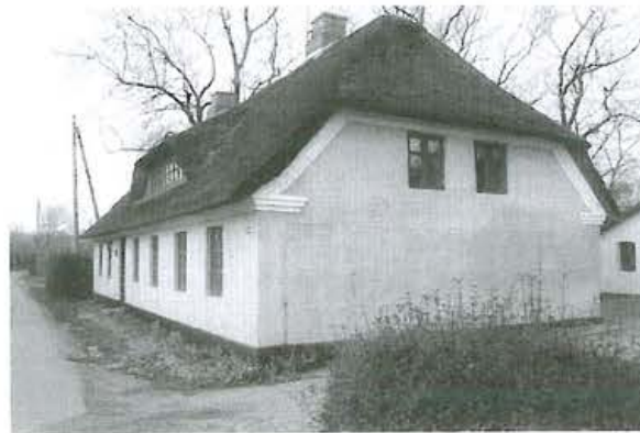
Lundovej 174 er en typisk smuk klassicistisk bygning. Den gulkalkede facade med den hvidkalkede aftrappede gesims løftes arkitektonisk af den sorttjærede sokkel. Stråtaget afsluttes ved et vandret afskåret tagskæg. Bemærk at bygningen er uden tagrende og vinduerne har ingen sølbænke.
