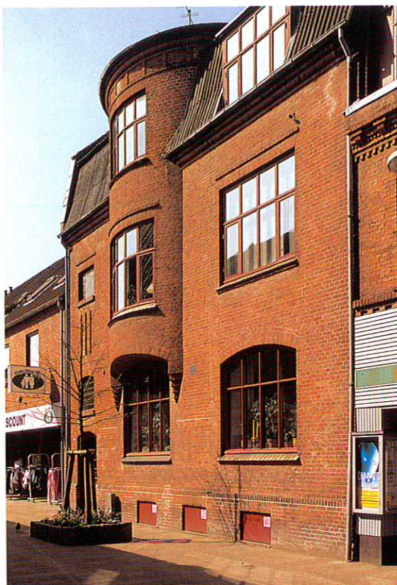
Nørregade 29 - blank mur
