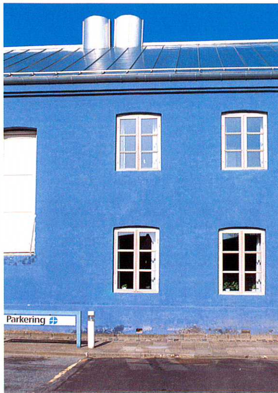
Frederiksgade 8 - vandskuret facade med godt farvevalg
