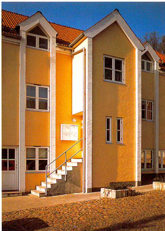
Adelgade 14 - nybyggeri med gode proportioner og sammenhæng i facaden
