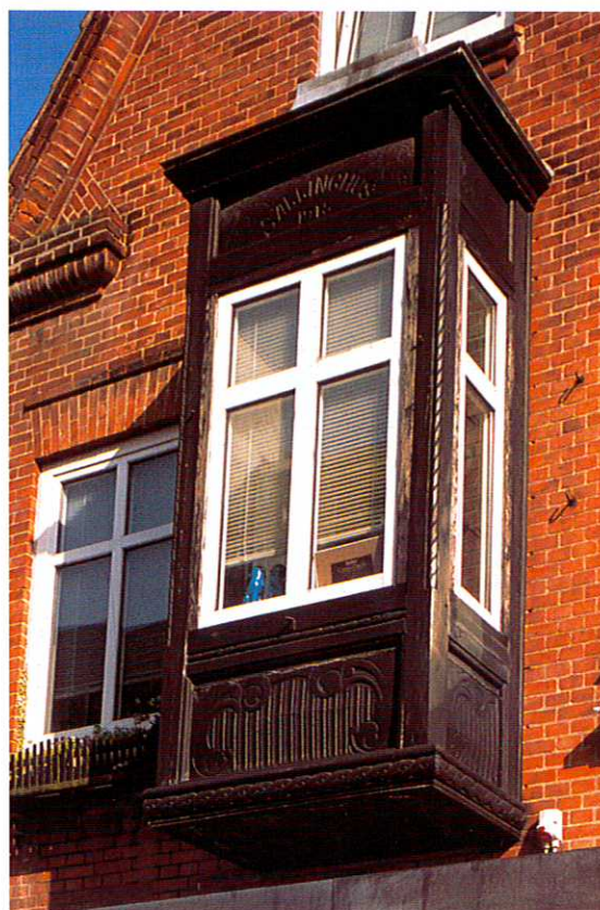
Nørregade 24-28 - detalje af facaden med karnap
