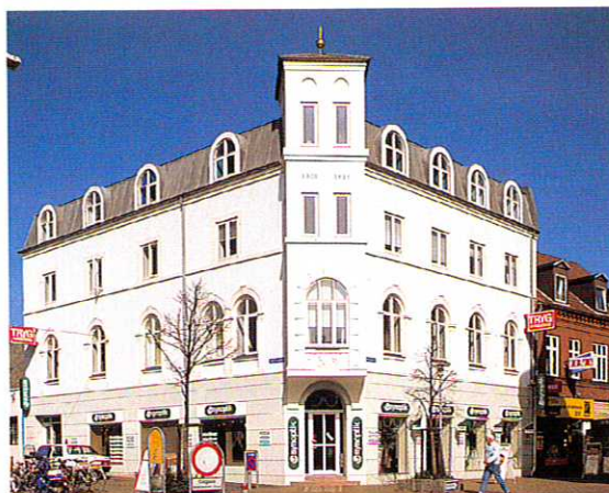
Adelgade 22 - facade, der opleves som en helhed. Ejendommen fik Skive kommunes Bygningspræmieringspris for 1991.
