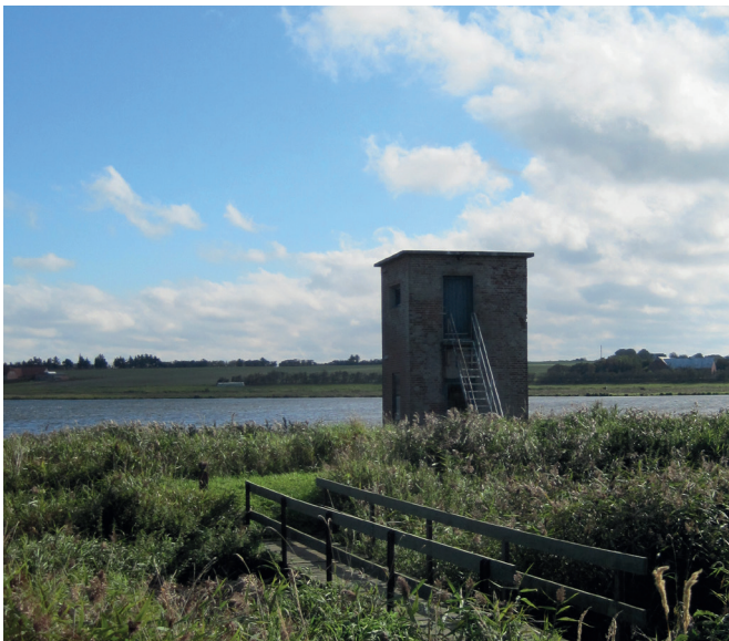
Foto: Pumpehuset/fugletårn ved Spøttrup Sø
