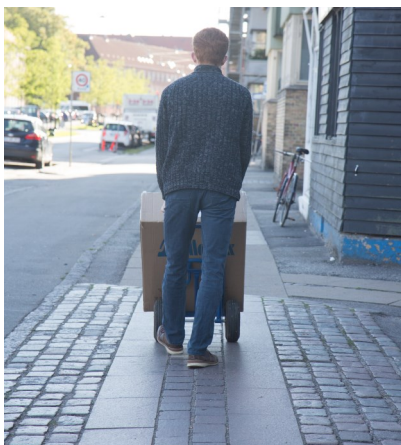
Billede 14: Brostenoverkørsel med jævn belægning. Gangbanen har dog ikke samme bredde som fortovet.
