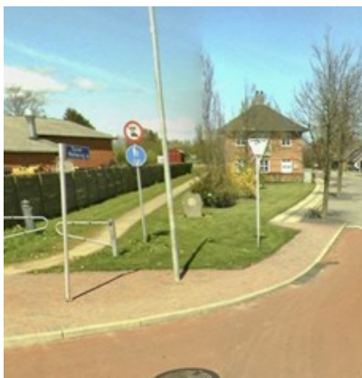
Billede 47: Standere ikke markeret i gangbane på Hovedgaden.
