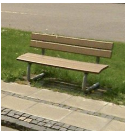
Billede 74: Bæk ved Stoholmvej mangler armlæn.
