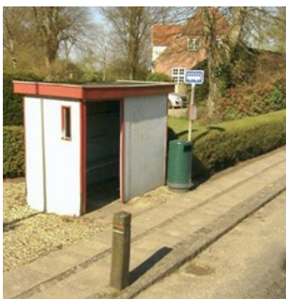
Billede 77: Læskærm på Sallingsundvej ikke tilgængelig for kørestolsbrugere. Der mangler korrekt belægning.
