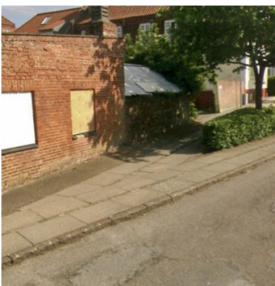
Billede 100: Der mangler opmærksomhedsfelter ved retningsskift på Jeppes Allé.
