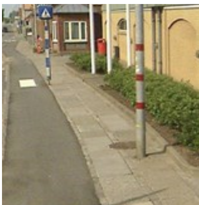
Billede 35: Delt sti på Søndergade mangler tydelig grænse mellem gangbane og cykelsti.
