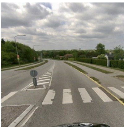
Billede 91: Reguleret overgang på Rosenbakken mangler taktile elementer.
