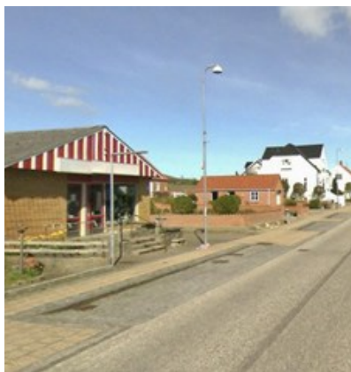
Billede 57: Retningsskifte på Bredgade er ikke markeret i belægning.
