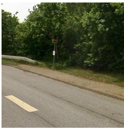
Billede 116: Busstop på Thorsvej mangler taktile elementer, læskærm og bæk.
