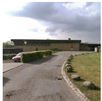
Billede 120: Ujævn belægning på Bilstrupvej.
