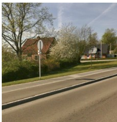
Billede 41: Delt sti på Aakjærvej mangler tydelig grænse mellem gangbane og cykelsti.
