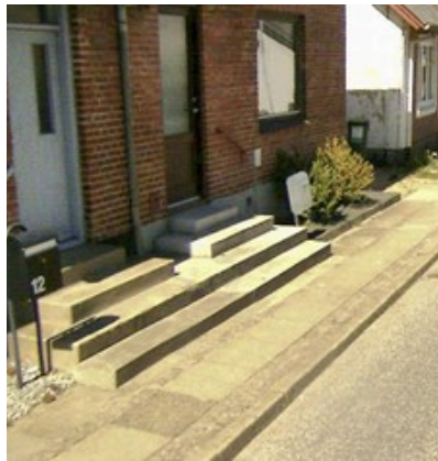
Billede 45: Trappeudspring i gangbane på Toustrupvej.
