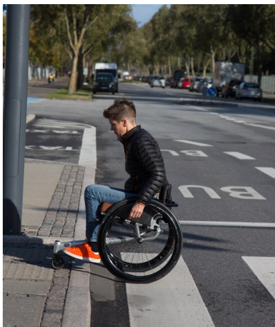
Billede 4: Kørestolsbruger ved kantsten med kantstensrampe.
