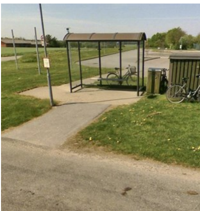
Billede 86: Bustop på Nørremarken mangler armlæn på bænk og korrekt belægning samt opspring mod kørebanen.
