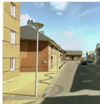
Billede 61: Der mangler opspring mod kørebane på Museumsvej.
