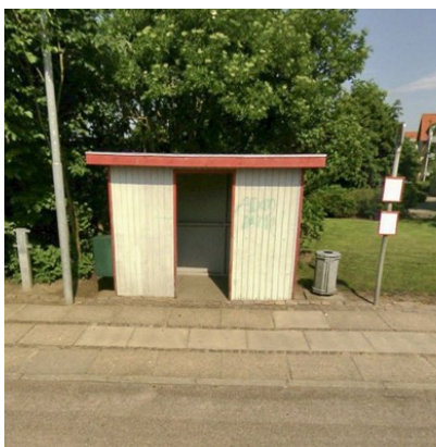
Billede 97: Busstoppested på Aage Nielsens Vej mangler opmærksomheds- og retningsfelt samt kantstensopspring mod cykelsti.
