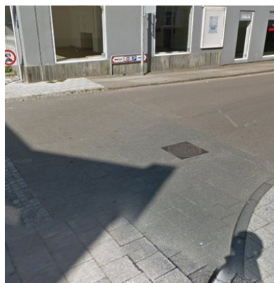
Billede 101: Uklarhed om vigepligt ved overkørsel på Christiansgade.
