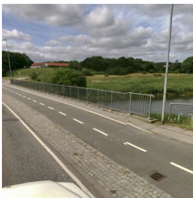
Billede 106: For smal gangbane på broen på Sdr. Boulevard.
