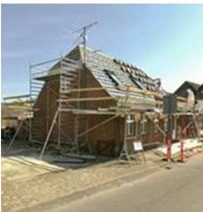
Billede 80: Stillads i gangbane på Østergade.
