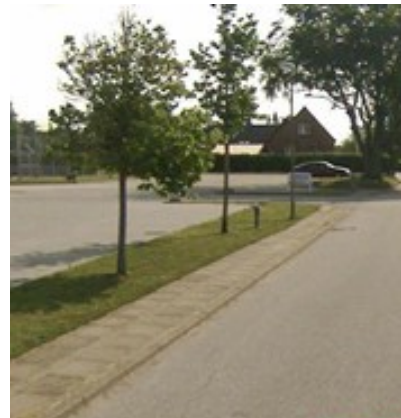
Billede 67: Gangbane på Skolevej mangler 80 cm jævn sammenhængende belægning.
