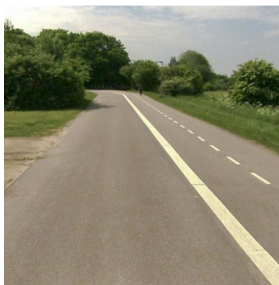
Billede 109: Dobbeltrettet fællessti på Arvikavej samt utilstrækkelig taktil kant til kørebanen.
