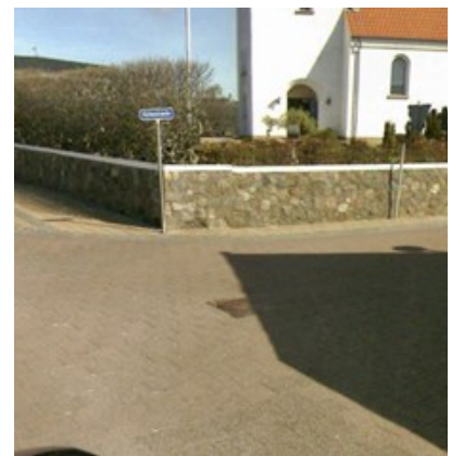
Billede 58: Kryds på Bredgade udformet med afvigende belægning. Uklarhed om vigepligt.
