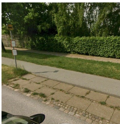
Billede 119: Retningsfelter, opmærksomhedsfelter og korrekt opspring mangler ved alle busstoppesteder på Dalgas Allé.
