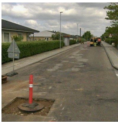
Billede 92: Ujævn belægning på Skovbakken.
