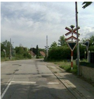
Billede 62: Der mangler markering i belægning ved jernbaneoverskæring og -bomme på Søbyvej.
