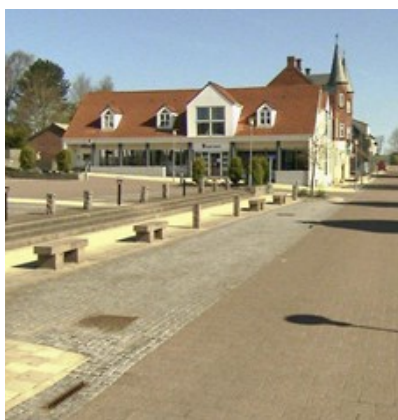
Billede 78: Bænke ved Jernbanegade mangler arm- og ryglæn. Der mangler opspring mod kørebane.
