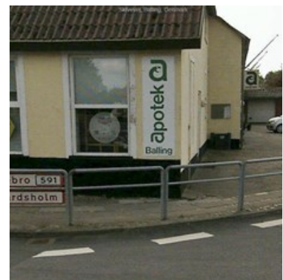
Billede 37: Rækværk på Søndergade mangler stokkeliste.
