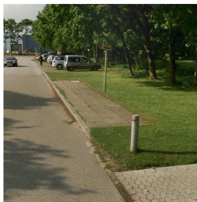
Billede 107: På Arvikavej mangler gangbane til busstop, samt læskærm, bænk og taktil belægning.
