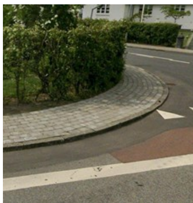
Billede 72: Belægning på Viborgvej mangler ledelinje.
